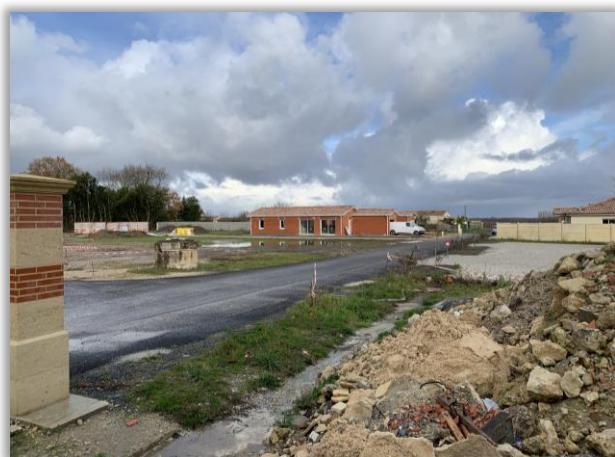
Une uniformisation des types d'habitat : pavillon contemporain en cours de construction
